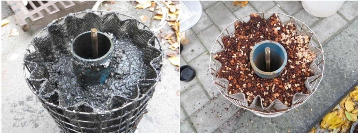
Abbildung 16: Filtersubstrat Anlage 1 (29.11.2015, links vor dem Austausch nach 11 Monaten Betrieb, rechts nach dem Austausch)
