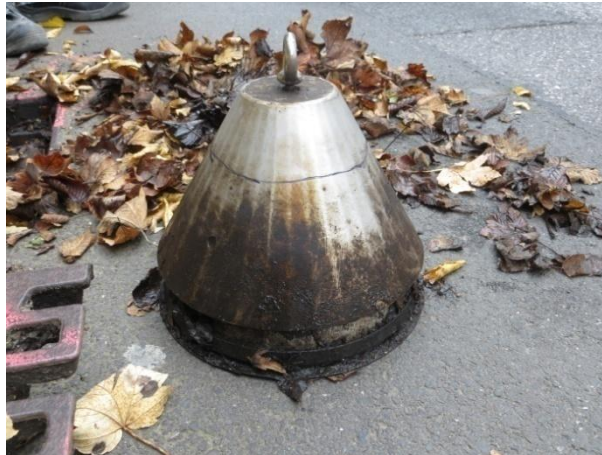
Abbildung 18: Verteilerkegel Anlage 1 mit markierter Höhe des Notüberlaufs (29.10.2015)
