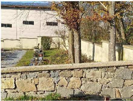
Friedhofsmauer wurde von Bewuchs befreit
